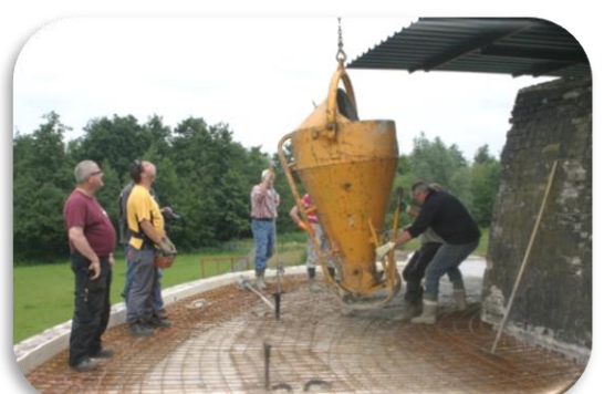
Foto 16: Het nieuwe dak wordt gestort
