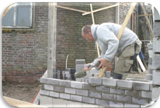
Foto 7: Het nieuwe bijgebouw wordt opgetrokken
