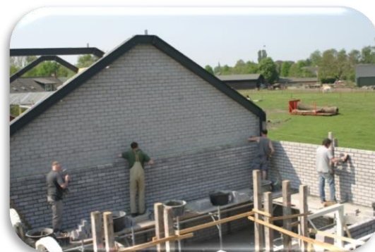
Foto 8: Het nieuwe bijgebouw wordt opgetrokken
