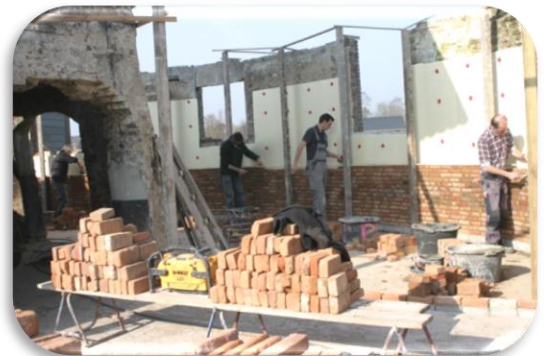
Foto 12: Metselen aan de molenromp
