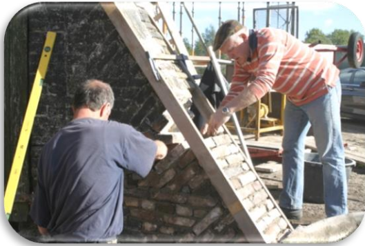
Foto 19: Een van de steunberen wordt gerepareerd
