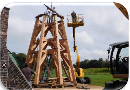
Foto 33: De achtkant wordt naast de romp opgebouwd
