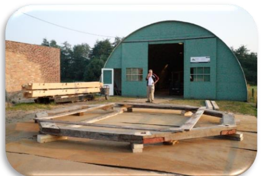
Foto 32: De achtkant wordt naast de romp opgebouwd
