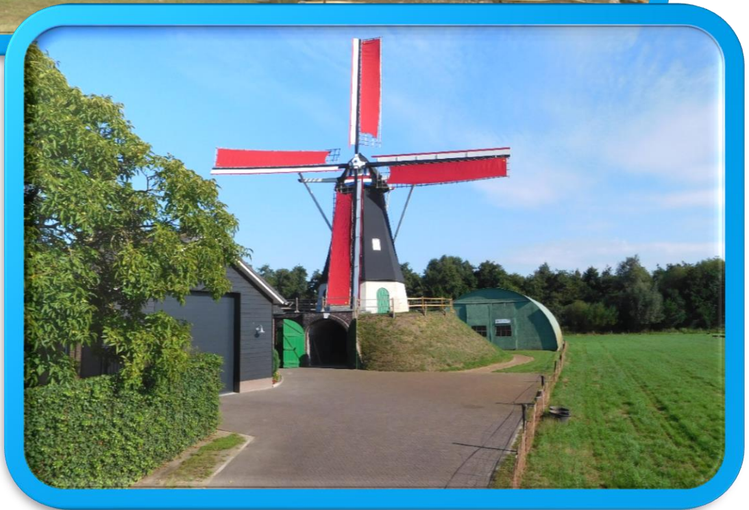
Foto 43 en 44: De molen voor en na de restauratie
