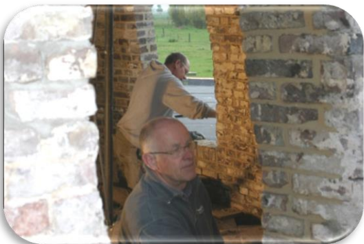
Foto 21: Het voegwerk van de molenromp wordt hersteld
