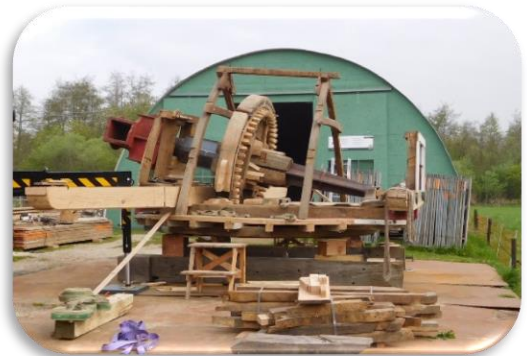
Foto 36: De oude kap arriveert op de bouwplaats
