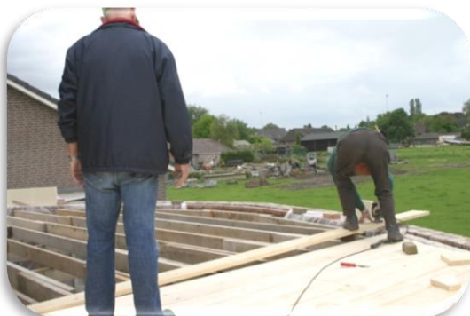
Foto 15: De bekisting voor het nieuwe betonnen dak
