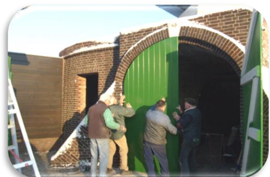
Foto 26: Nieuwe deuren in de inrijpoort
