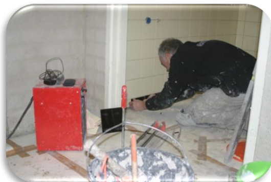
Foto 13: De toiletruimte wordt betegeld
