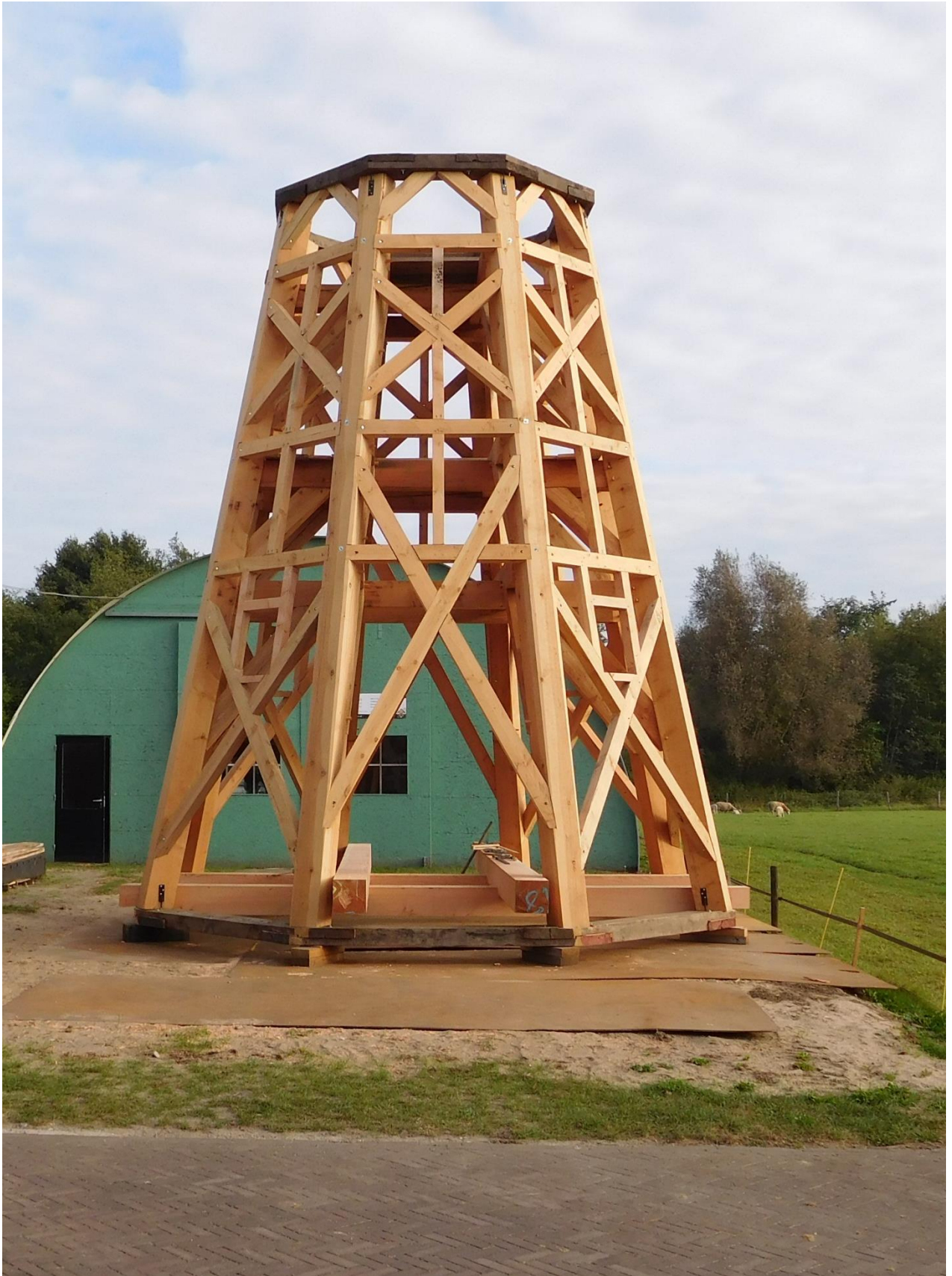
Foto 2: De achtkant met z'n zware balken en vakkundig aangebrachte pen- en gatverbindingen. Het is een fantastisch gezicht.
