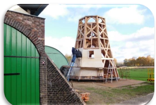
Foto 34: De achtkant wordt naast de romp opgebouwd
